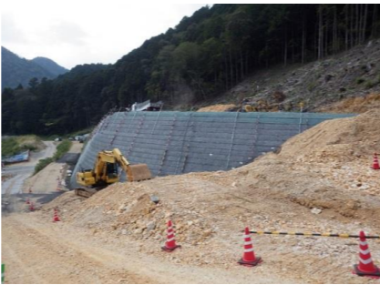
施工箇所(工事用道路部撮影)
