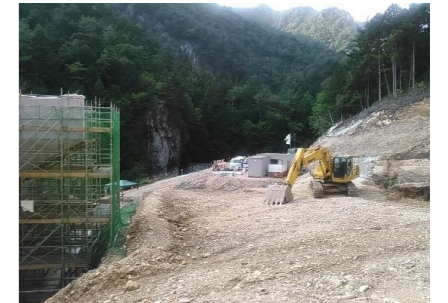
施工箇所(東から撮影)
