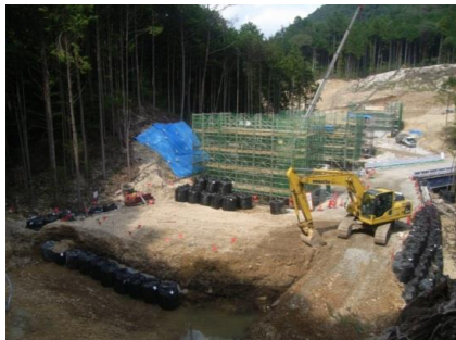
施工箇所(西から撮影)
