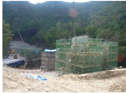
施工箇所(東から撮影)
