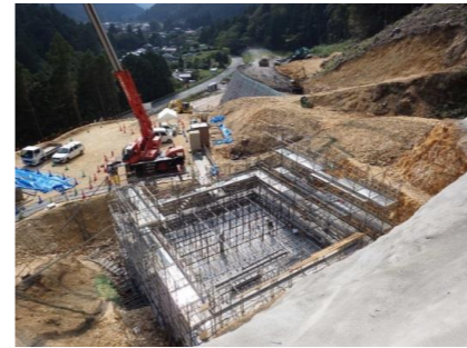
施工箇所(橋台部撮影)
