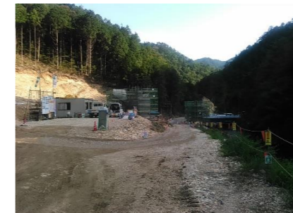
施工箇所(北から撮影)
