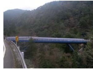
施工箇所（西から撮影）
