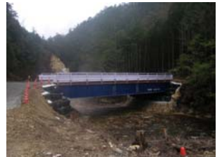
施工箇所（東から撮影）
