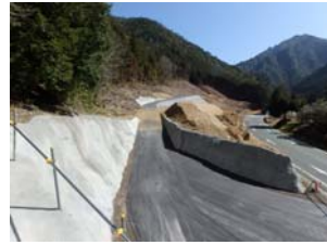
施工箇所（西から撮影）
