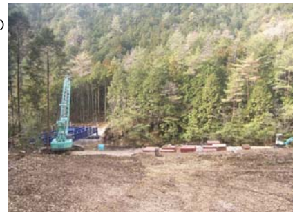
施工箇所（東から撮影）
