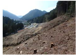
施工箇所（東から撮影）
