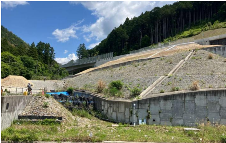
工事状況(管理用道路)
