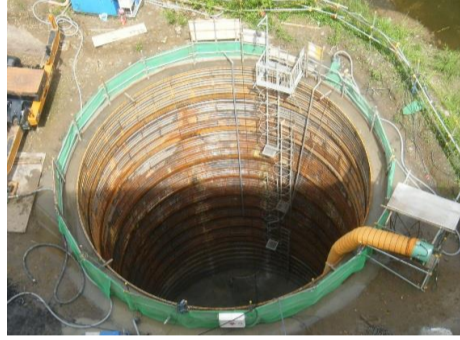
深礎工施工箇所
