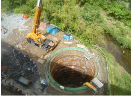
施工箇所全景
