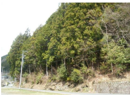
4号トンネル管理用道路設置予定箇所
