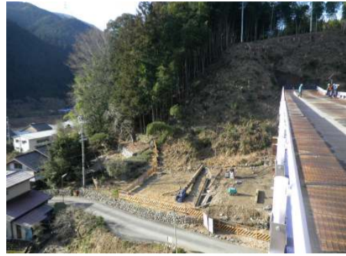
施工箇所写真(東から撮影)
