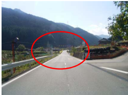
函渠工施工箇所
