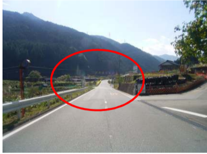
函渠工施工箇所
