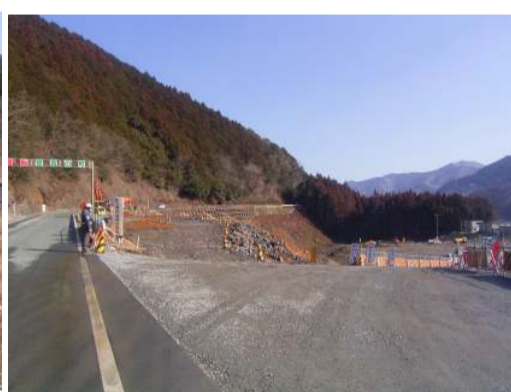
国道473号線迂回路部
