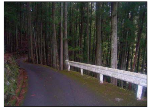
工区終点より起点方向を望む
