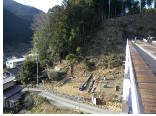
施工箇所写真(東から撮影)
