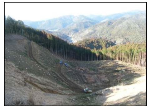
【伐採作業箇所(横見)】
