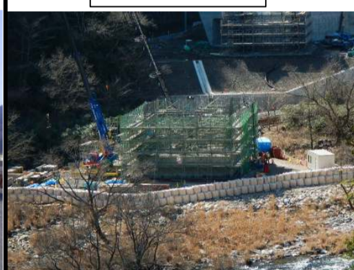
左岸側から見た現況
