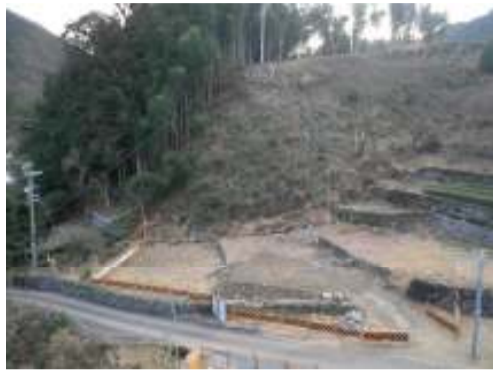
施工箇所写真(東から撮影)
