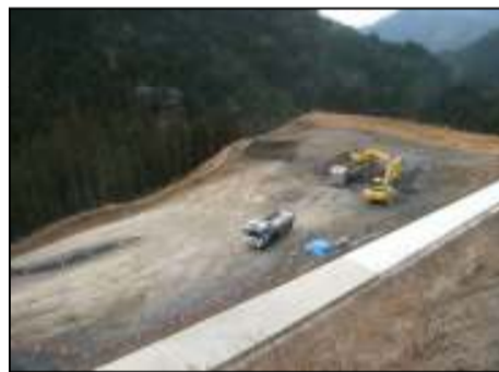
【掘削作業箇所(東栄IC部)】
