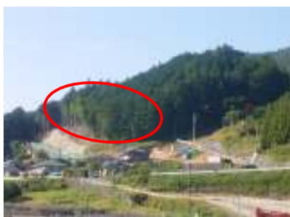
本線土工事・法面工事施工予定箇所
