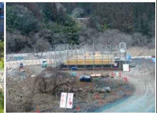
右岸側から見た状況
