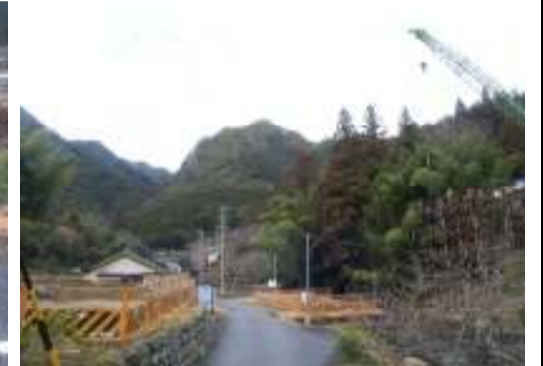
仮橋架設状況(道路より望む)
