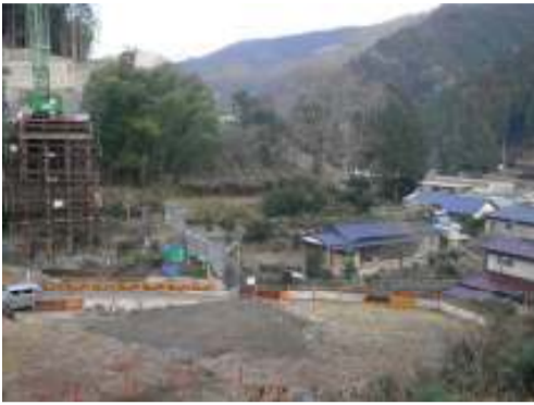
施工箇所写真(西から撮影)
