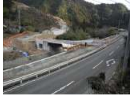
国道151号線より現場を望む。
