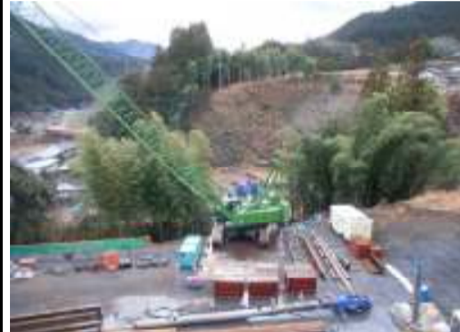
仮橋架設状況(発進側より望む)
