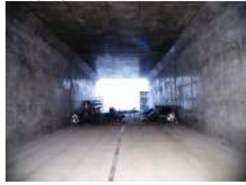
1号函渠内部 施工完了直後のようす
