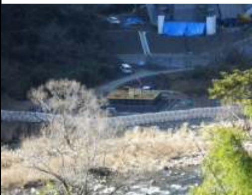
左岸側から見た現況
