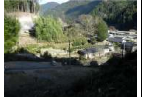
施工箇所写真(東から撮影)
