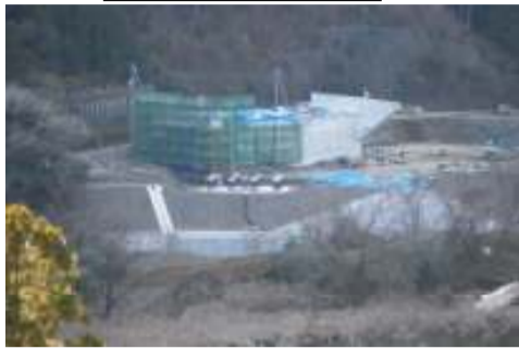
左岸側から見た現況
