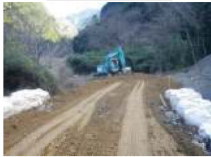
進入路盛土状況
