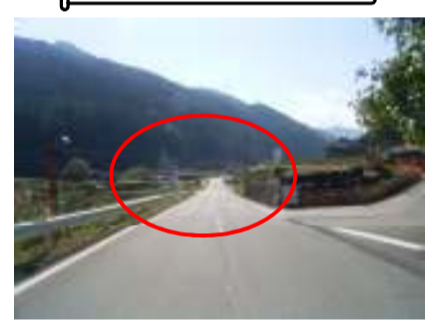
函渠工施工予定箇所
