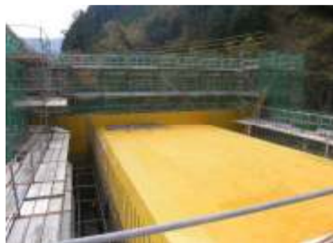
函渠構築状況
