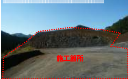
施工箇所を終点側より望む
