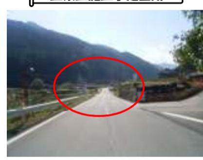
函渠工施工予定箇所
