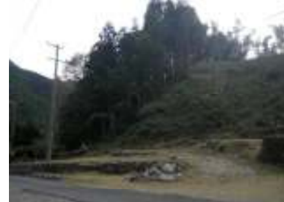
施工箇所写真(東から撮影)
