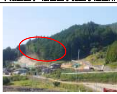
本線土工事・法面工事施工予定箇所
