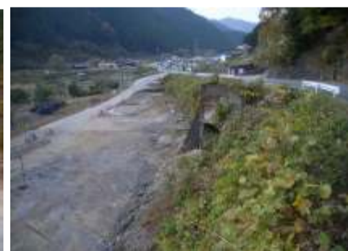
国道473号線迂回路部
