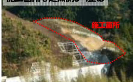
施工箇所を起点側より望む
