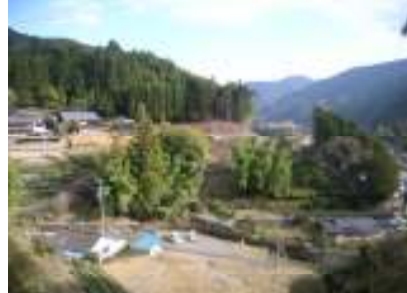
施工箇所写真(西から撮影)
