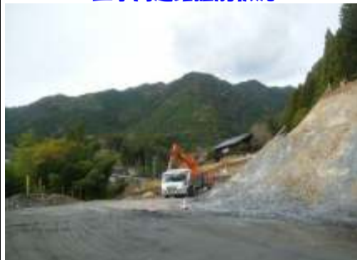
工事用道路掘削状況
