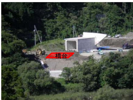
場所打杭施工準備(ヤード造成)状況
