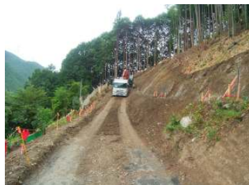
工事用道路掘削・積込状況
