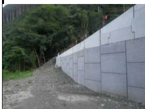
3号補強土壁施工完了
