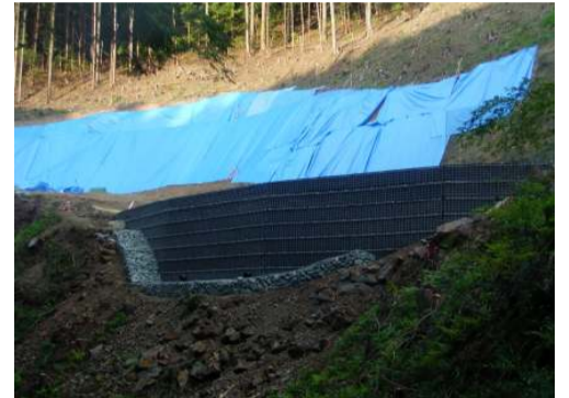
トンネル工事用仮設道路の様子
