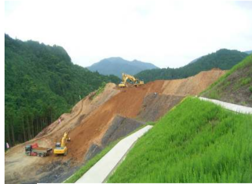
本線部分の掘削を行っています
