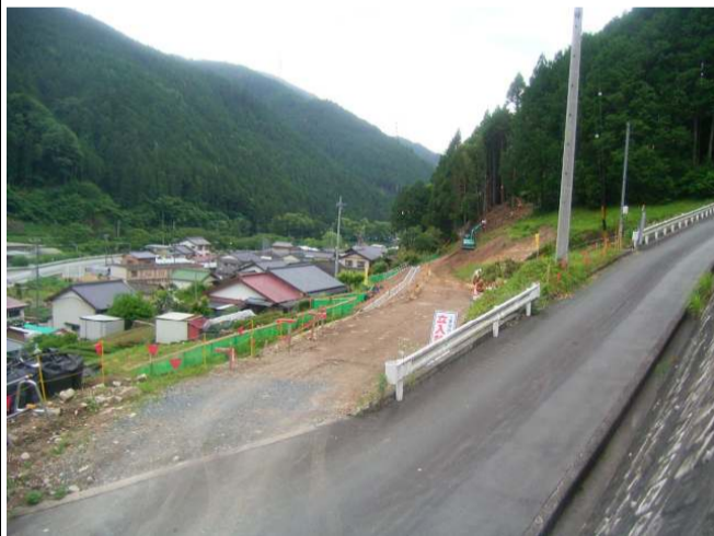
工事用進入路の現在
