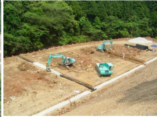
地下排水パイプの施工状況
