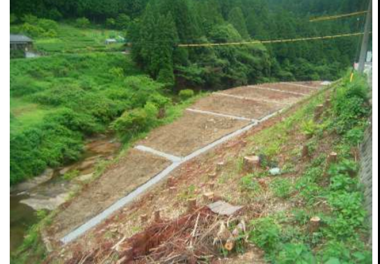
地下排水設備が完了しました。
