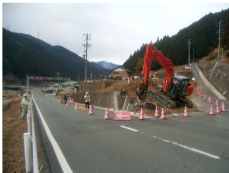
伐採木を再利用したチップを敷き詰めて道路のドロ汚れを防止しています。
