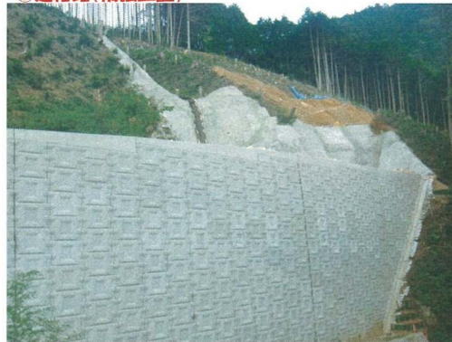
①連絡路(補強土壁)
