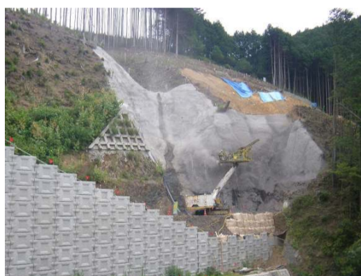
①連絡路(補強土壁)
