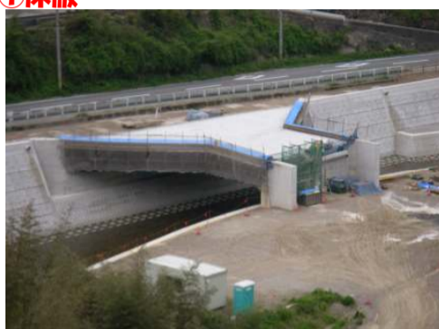
崩落部復旧 ②工事用道路
