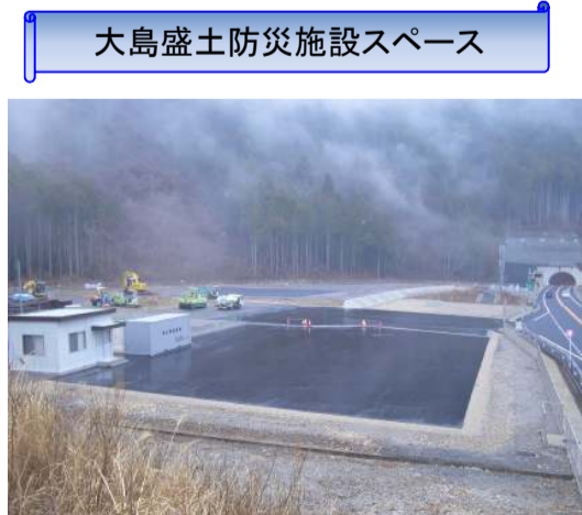
アスファルト舗装をして完成です。
