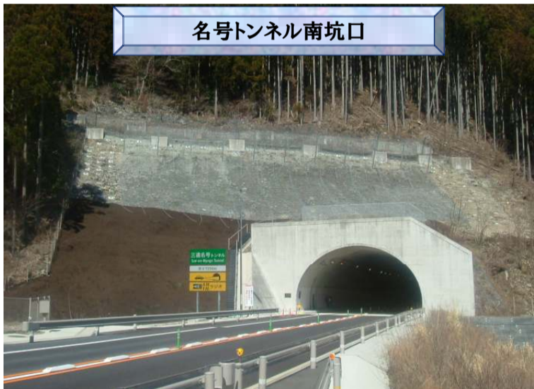
落石防止網、法面の種子吹付をして坑口周りを整備しました。
