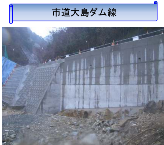
水沢地区の崩落箇所を復旧しました。
