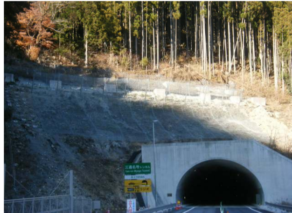
名号トンネル両坑口において、落石対策のための落石防止網を設置しました。
