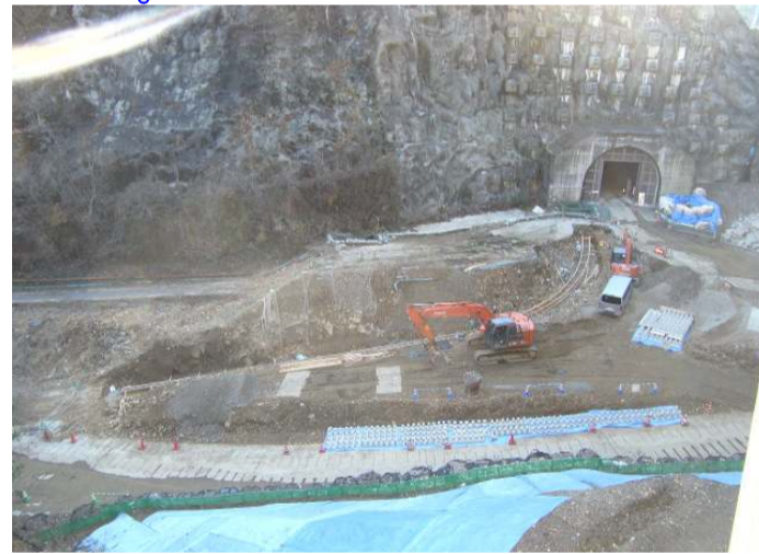
避難連絡路のブロック積を始めました。
