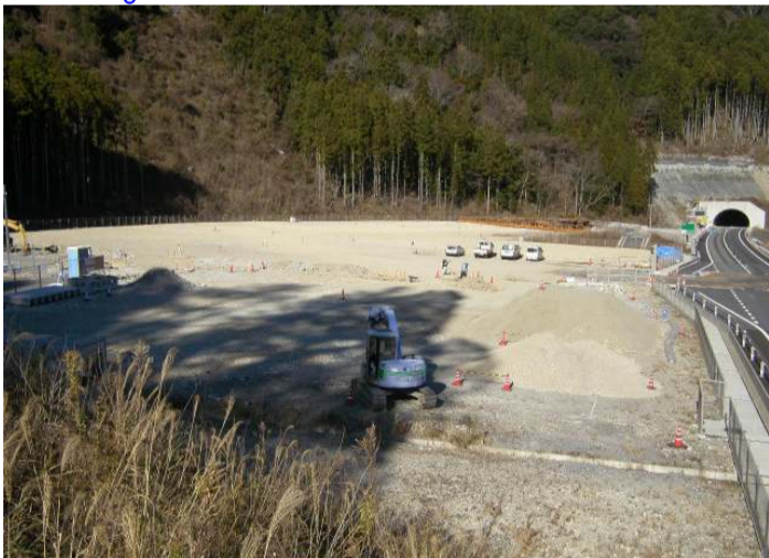
排水構造物の施工を始めました。
