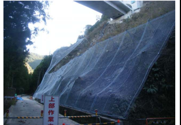
名号トンネル北坑口下
