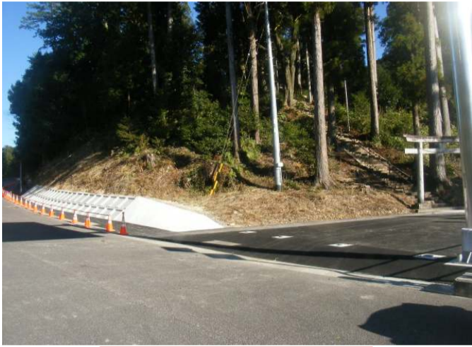
歩行者通路を舗装しました。
