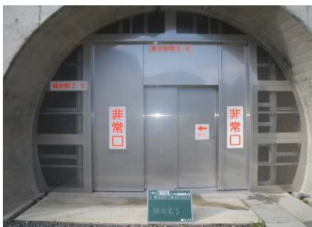
トンネル入口
