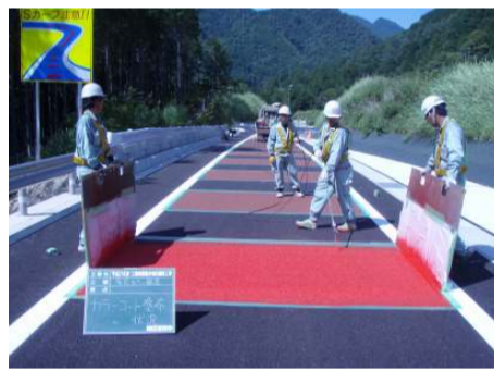
工事進捗状況【名号地区】
