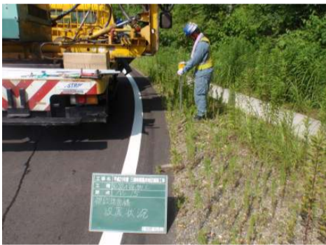
工事進捗状況【大島地区】
