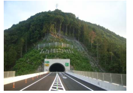
【名号トンネル上部北坑口斜面部】
