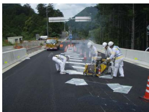
工事進捗状況【名号地区】
