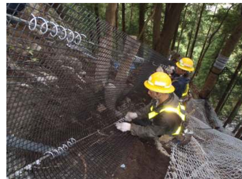
【名号トンネル上部北坑口斜面部】
