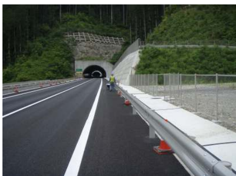
工事進捗状況【大島地区】
