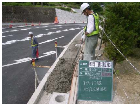
【連絡路入口付近】
