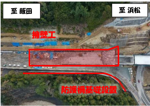
鳳来峡IC(本線部)
