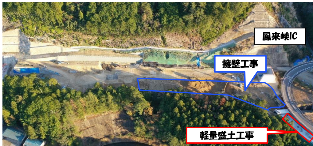
工事箇所全景
