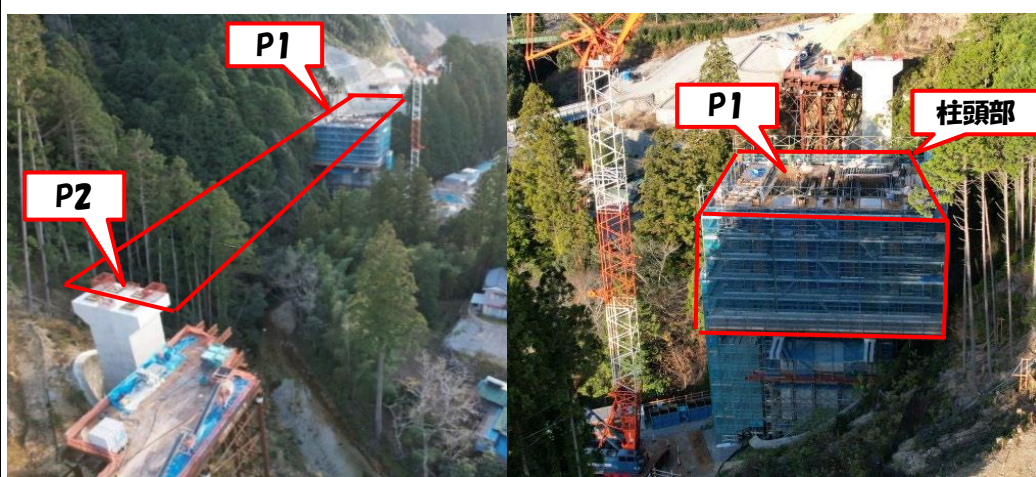
工事箇所全景
