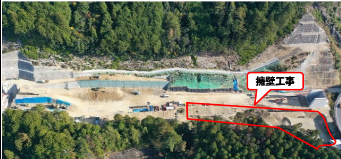
工事箇所全景
