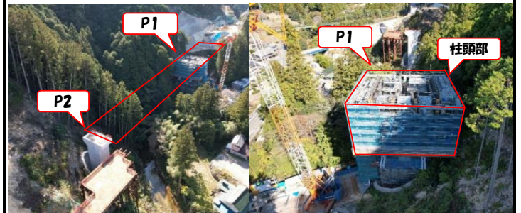
工事箇所全景
