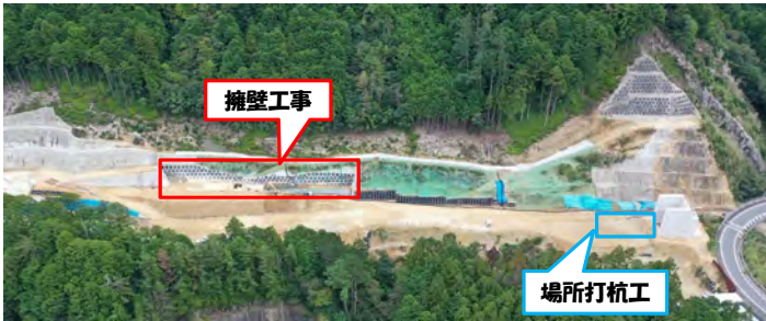
工事箇所全景
