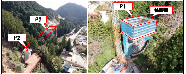
工事箇所全景
