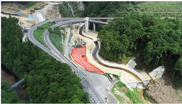
工事箇所全景
