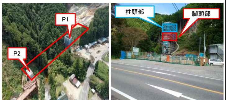
工事箇所全景
