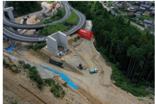
工事箇所全景
