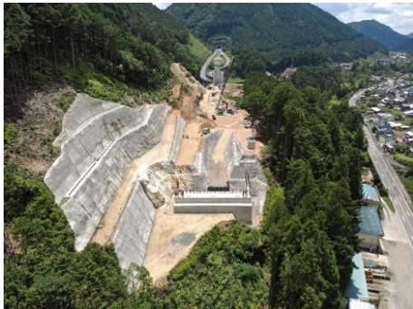
工事箇所全景
