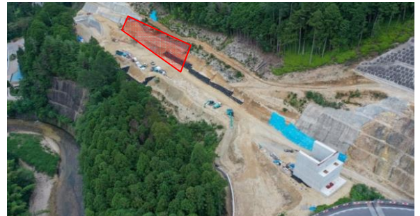
法面工事 施工箇所
