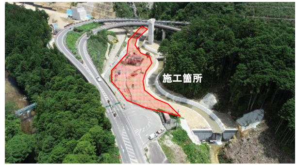
工事箇所全景
