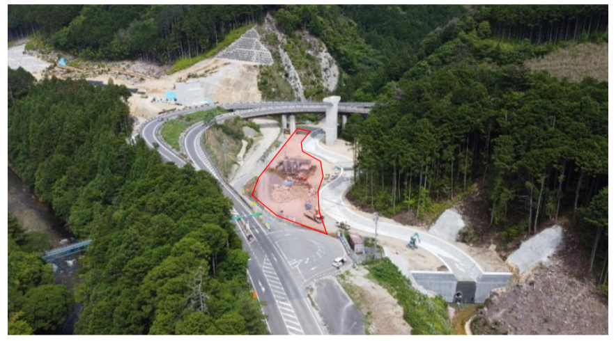
工事箇所全景
