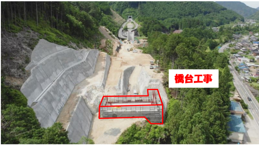
工事箇所全景
