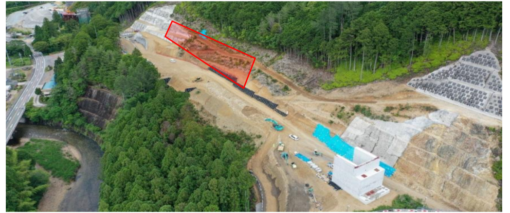
法面工事 施工箇所
