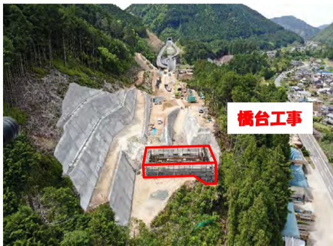
工事箇所全景
