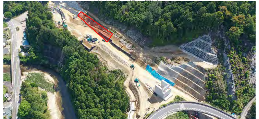
法面工事 施工箇所
