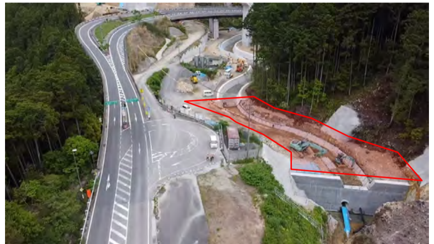
工事箇所全景
