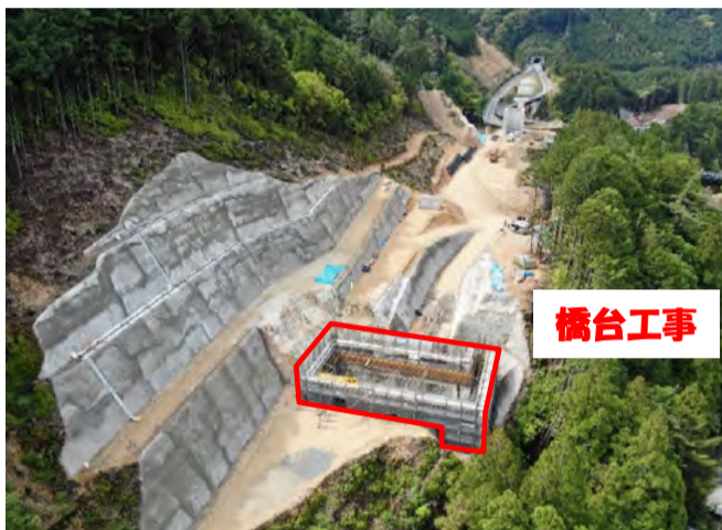
工事箇所全景
