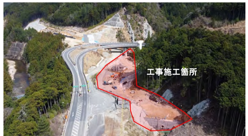
工事箇所全景
