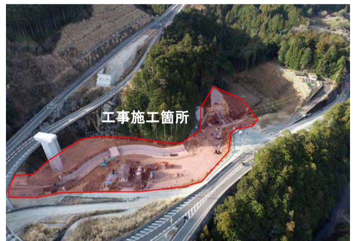
工事箇所全景
