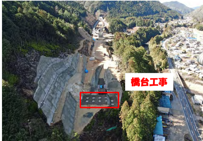
工事箇所全景
