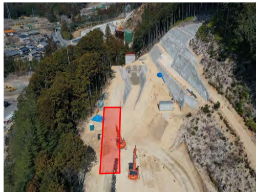
地盤改良工事 施工箇所
