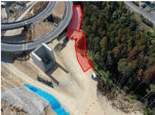
擁壁・函渠工事 施工箇所
