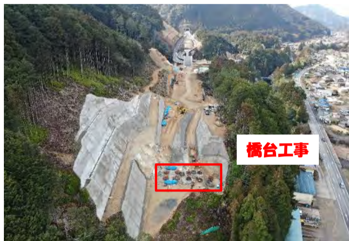
工事箇所全景
