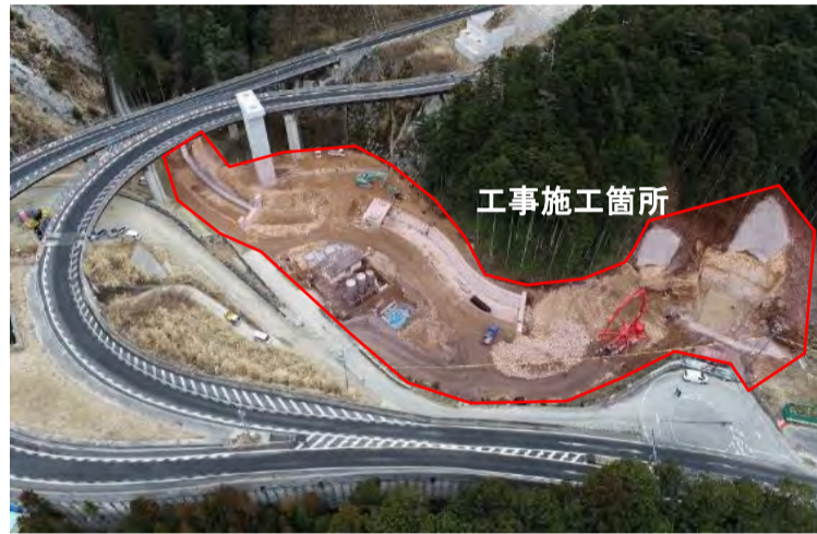
工事箇所全景
