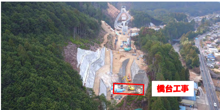
工事箇所全景
