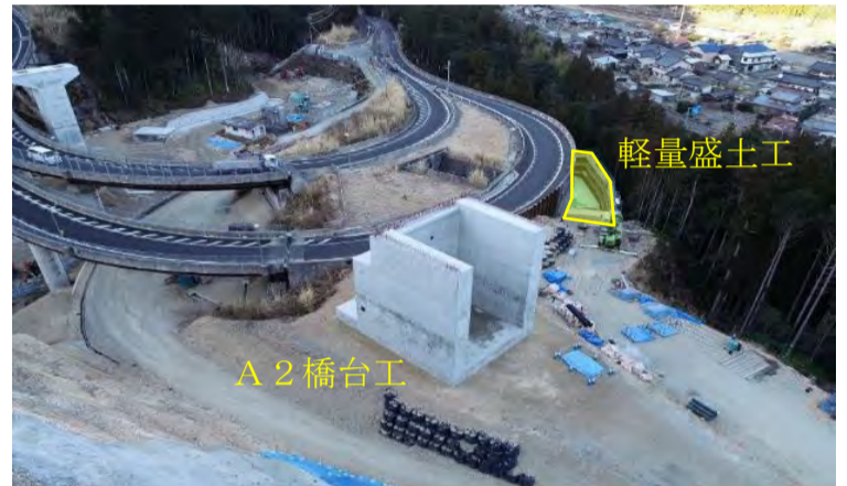
工事箇所全景
