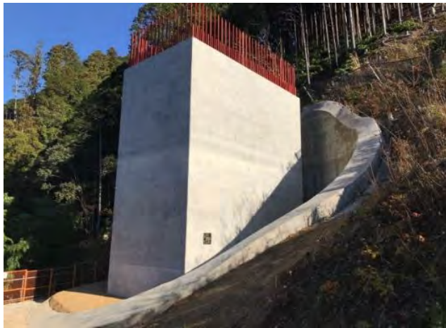
工事箇所全景
