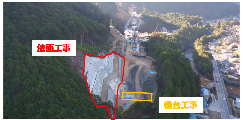
工事箇所全景
