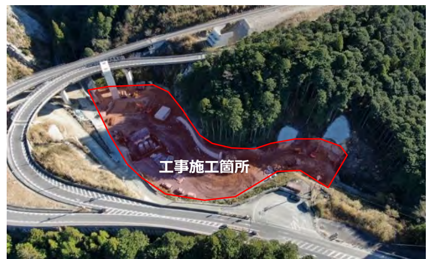
工事箇所全景
