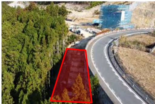
軽量盛土工(盛土)
