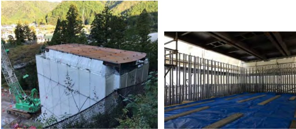
工事箇所全景
