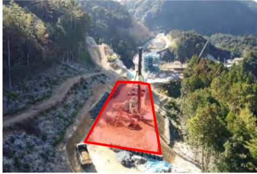
地盤改良工事
