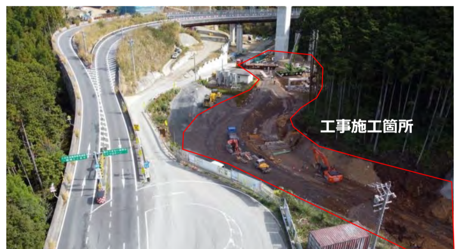
工事箇所全景
