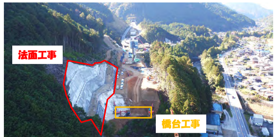
工事箇所全景
