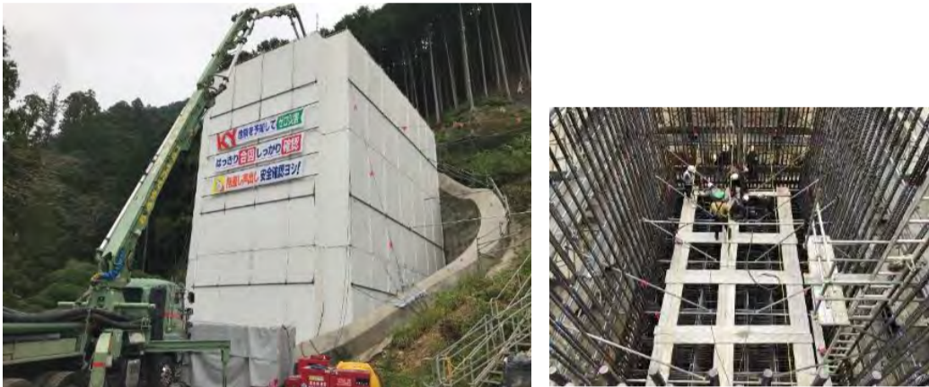
工事箇所全景
