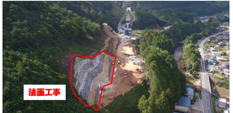
工事箇所全景
