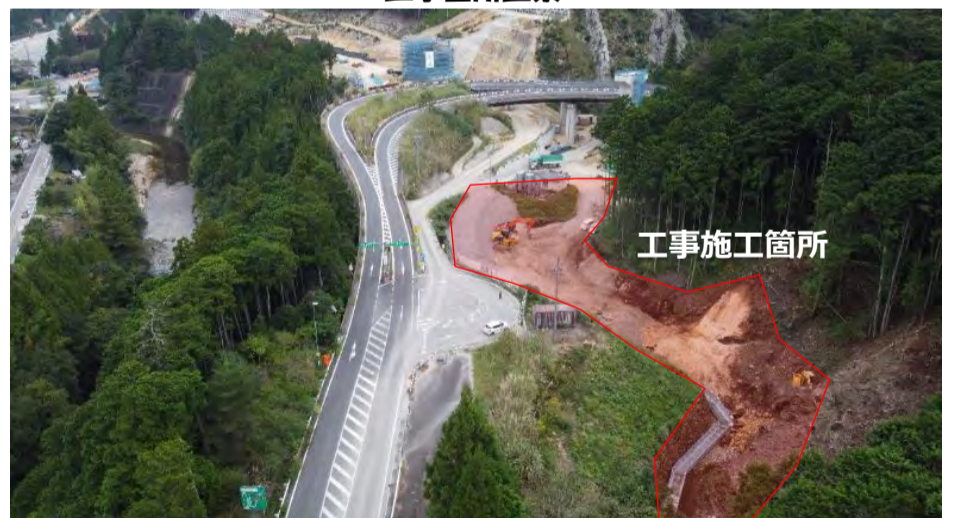
工事箇所全景
