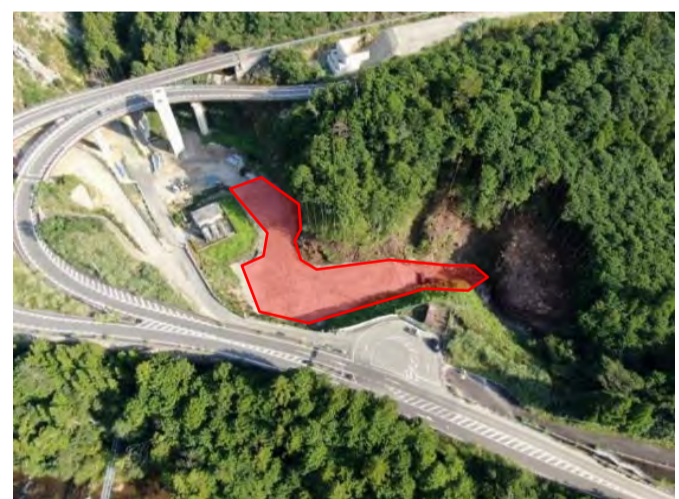
工事箇所全景
