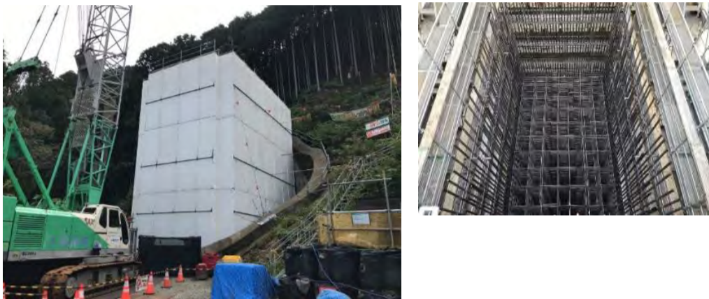
工事箇所全景
