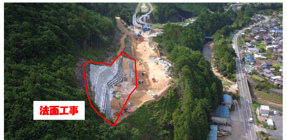
工事箇所全景
