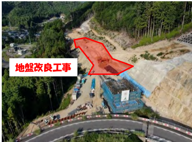
工事箇所全景
