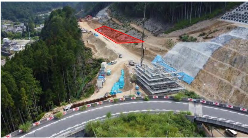
工事箇所全景
