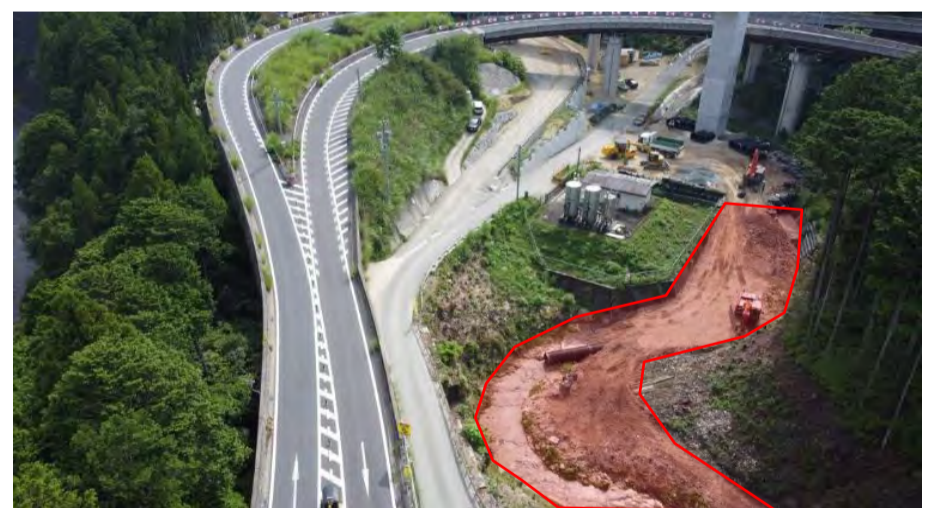
工事箇所全景
