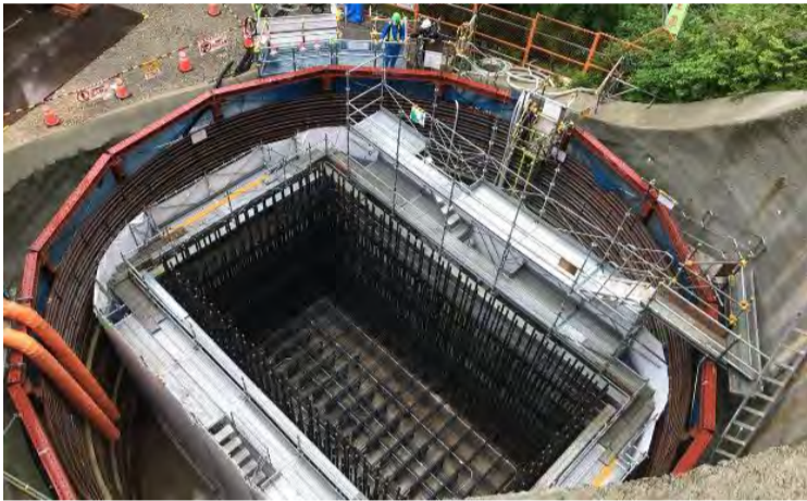
工事箇所全景
