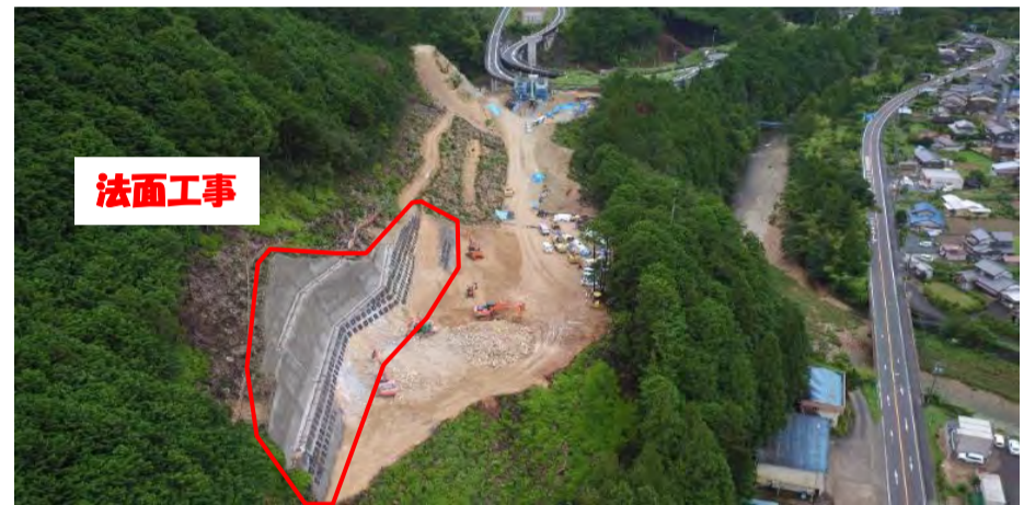
工事箇所全景
