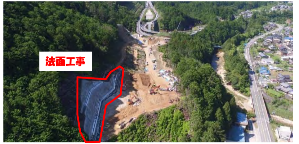
工事箇所全景
