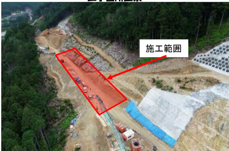
工事箇所全景
