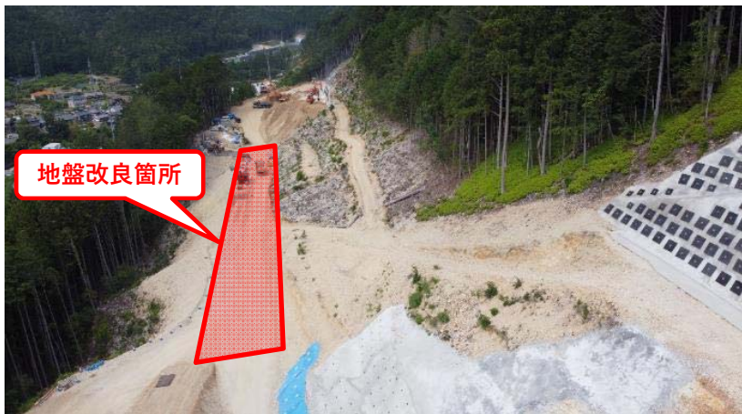
工事箇所全景
