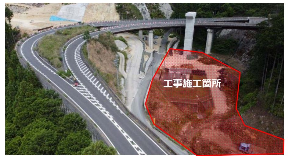
工事箇所全景
