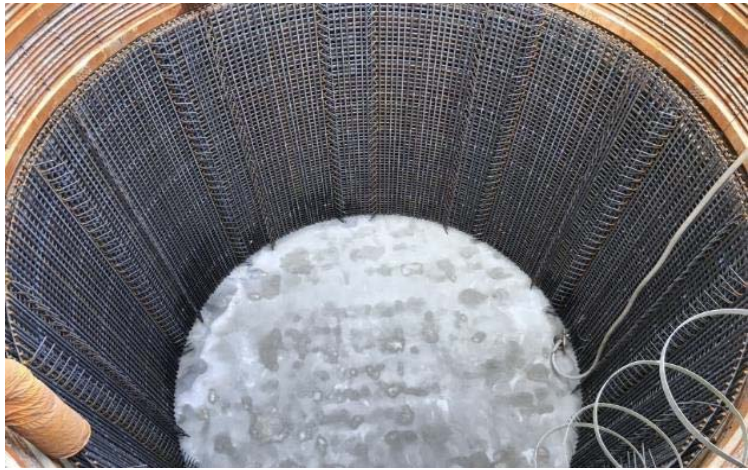
工事箇所全景
