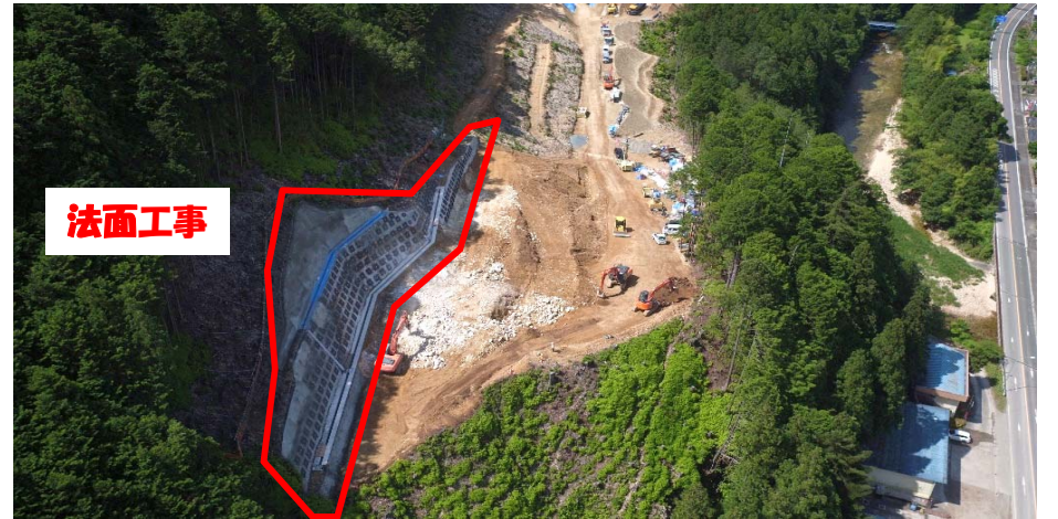
工事箇所全景
