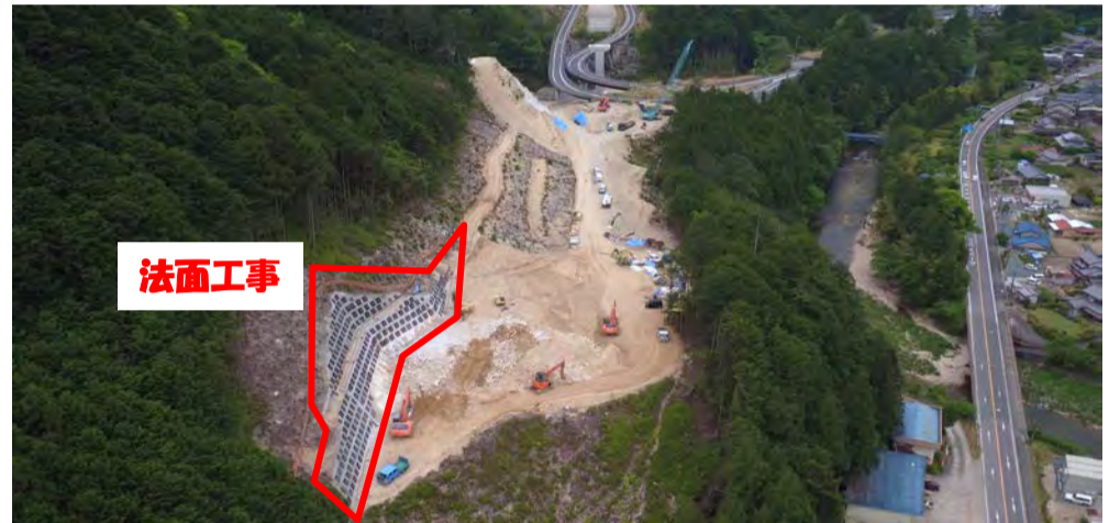
工事箇所全景
