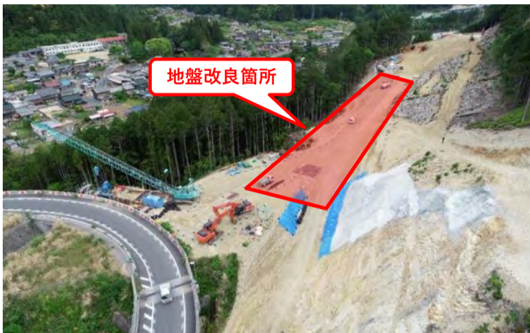
工事箇所全景
