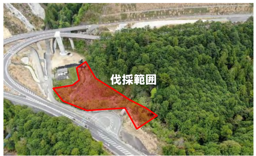
工事箇所全景
