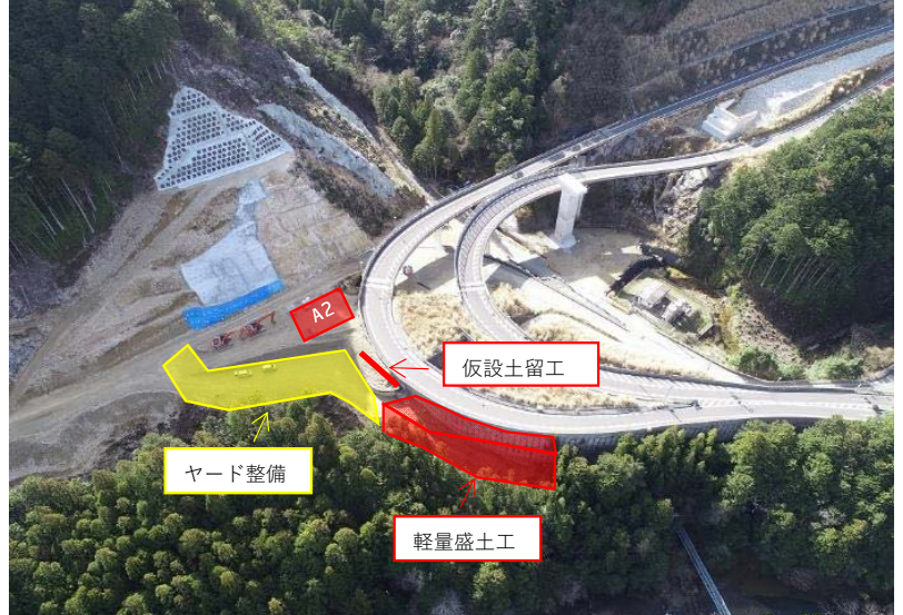
工事箇所全景
