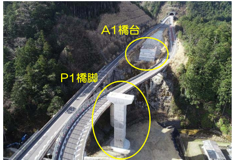
工事箇所全景
