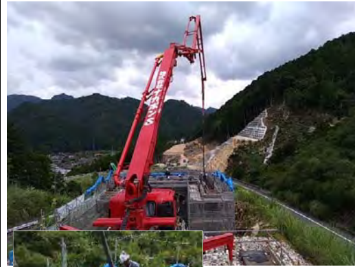
胸壁、翼壁 コンクリート 打設状況
