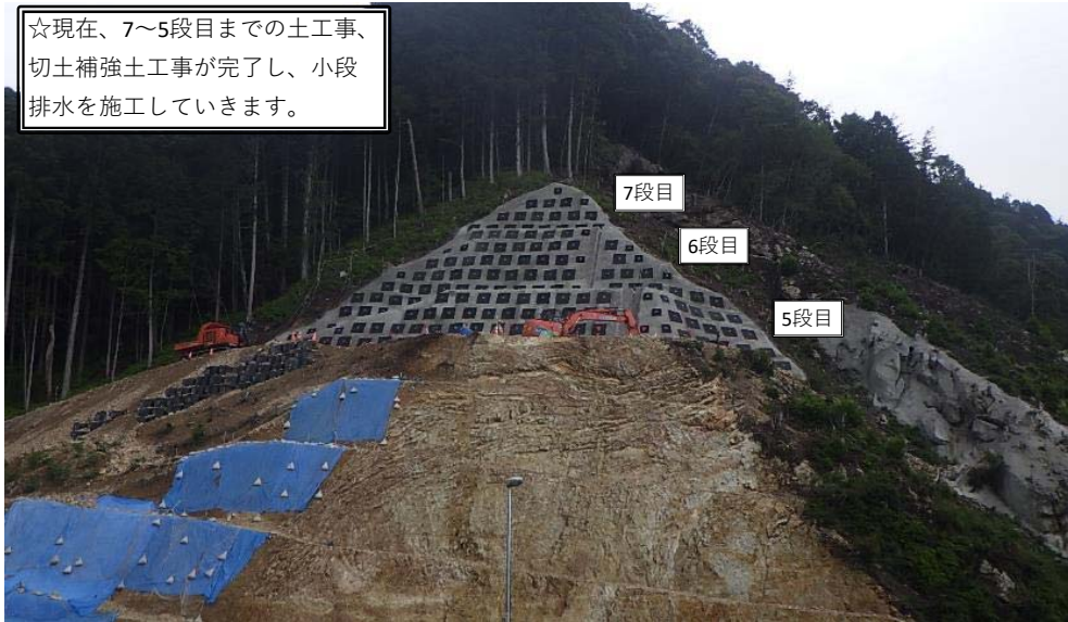
山側機能補償道路の法面工事
