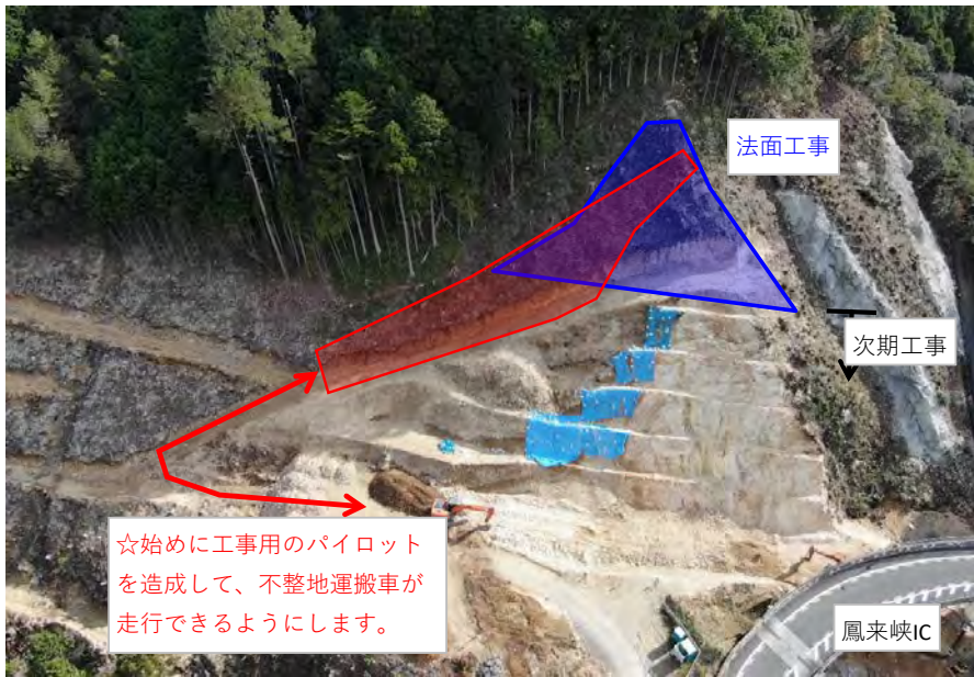
9号橋P1橋脚の仮設ヤード造成工事
