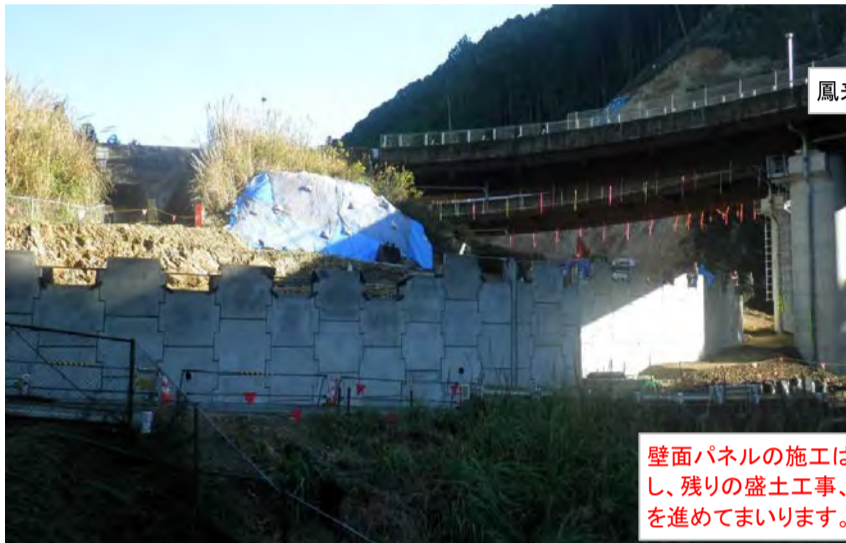
Cランプの5号補強土壁工事
