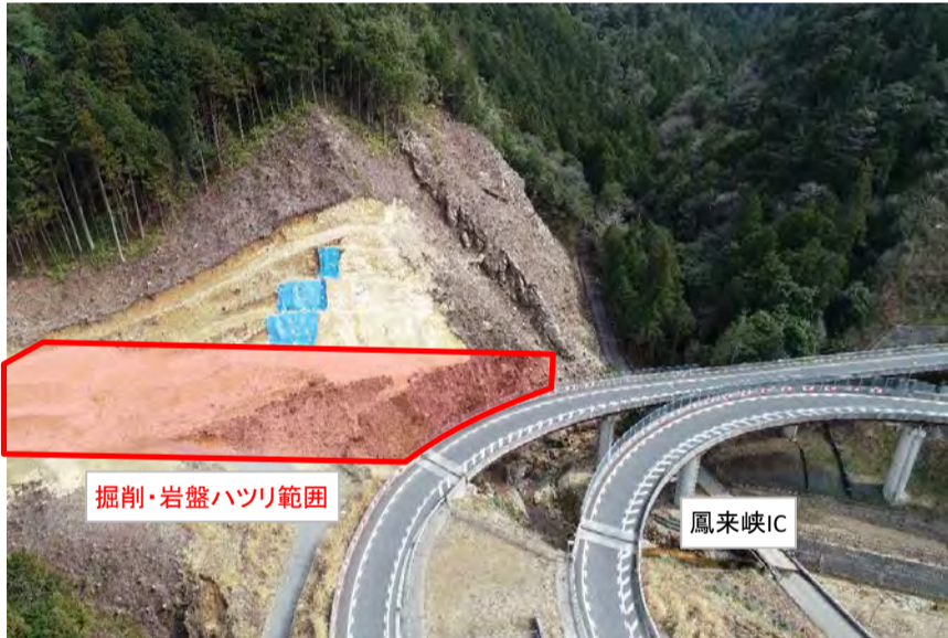
Cランプの掘削工事
