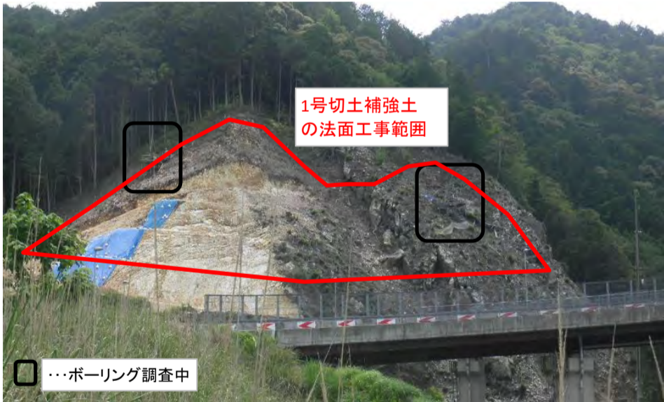
1号切土補強土の法面工事着手前のボーリング調査
