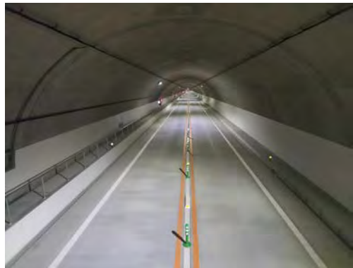
トンネル坑内(満川⇒川合)
