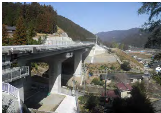
川合2号橋高架下
