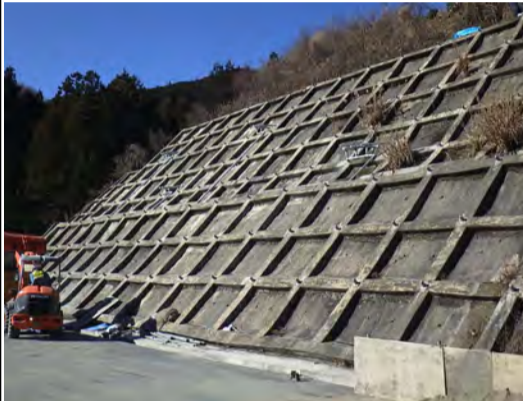
川合工区法面工完了
