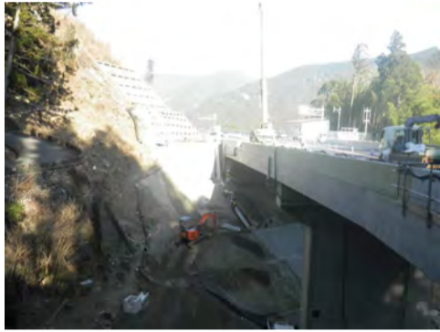
川合2号橋高架下
