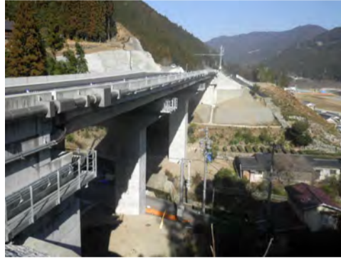
川合2号橋高架下
