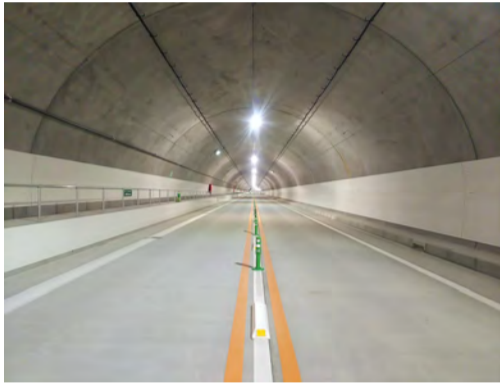
トンネル坑内(浦川⇒川合)
